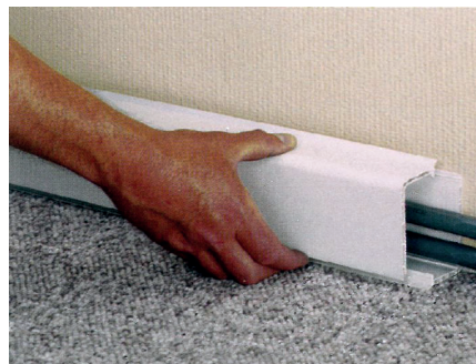
25. Front-panelet trykkes let på plads. Forbindelse øverst og nederst skal ske samtidig
