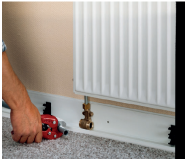
10. Røret afkortes ved panel-armaturets gevindstart.
