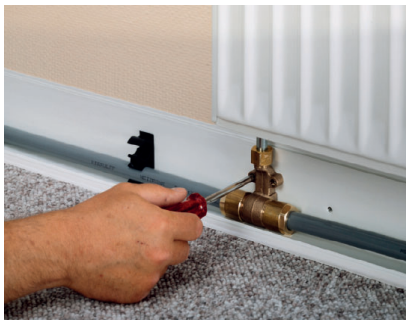
13. Panel-armaturet skrues fast på rørpanelet med medfølgende selvskærende skruer.
