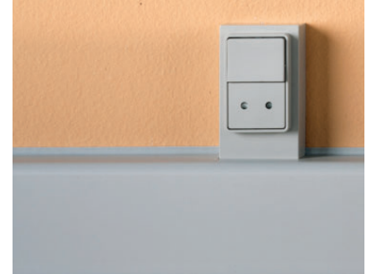
36. Der udskæres i frontpanelet, som monteres for færdig installation.
