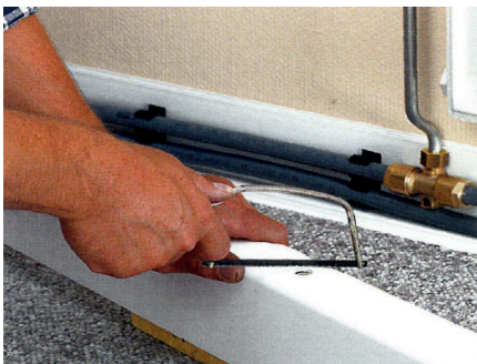
24. Udsækning til stålør-sæt bores og saves.
