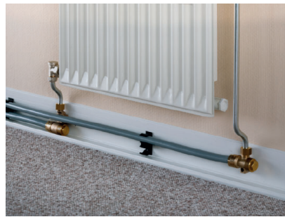
20. Til afslutning på frem- og returløb anvendes panelarmatur-sæt, sidste. Forberedt for senere udvidelse.
