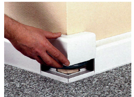
26. Det udvendige hjørne trykkes let på plads i det vægmonterede front-panel.
