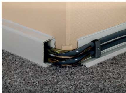
22. Ved udvendigt hjørne afskæres frontpanelet som vist ovenfor. Frontpanelet skæres rent og i ret vinkel.
