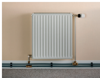
14. Efter færdig montage foretages trykprøvning ved 10 bar.
