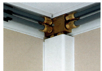
42. Colombusæg monteret i hjørne ved loft.
