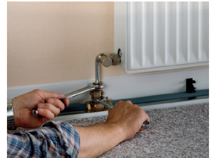
12. Glidemiddel påføres. Fastspænd tilslutningen til radiatoren. Benyt den rigtige nøglestørrelse, og hold kontra.
