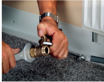
11. Stålrørs-tilslutningen afmonteres, Gabotherm-røret fastspændes til panel-armaturet.
