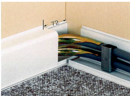
21. Ved indvendigt hjørne afskæres frontpanelet som vist ovenfor.
