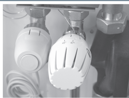
Telestaten tilsluttes styreenheden.
