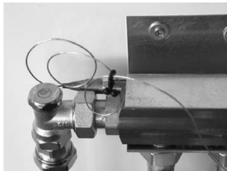
Føleren anbringes mellem blanderør og ophængsbeslag.
