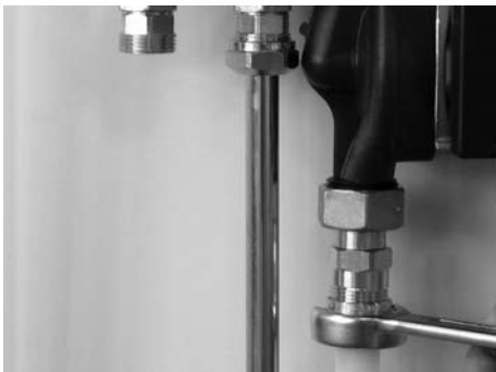
Tilslut frem gulvvarme.
