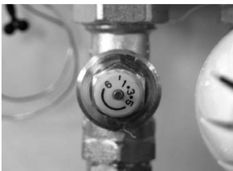
Indregulering foretages på forindstillingsskruen.
