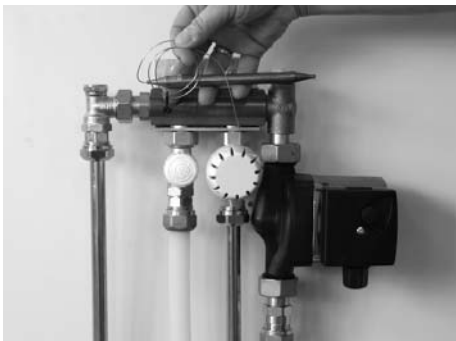
Følerelement for termostatventil.
