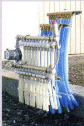
Komplet montering 2 grens til færdig blandesløjfe
