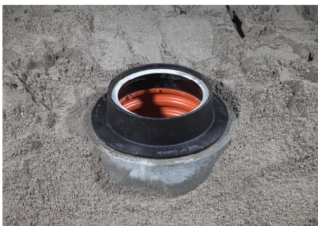
Karmen sættes på beton keglen.
