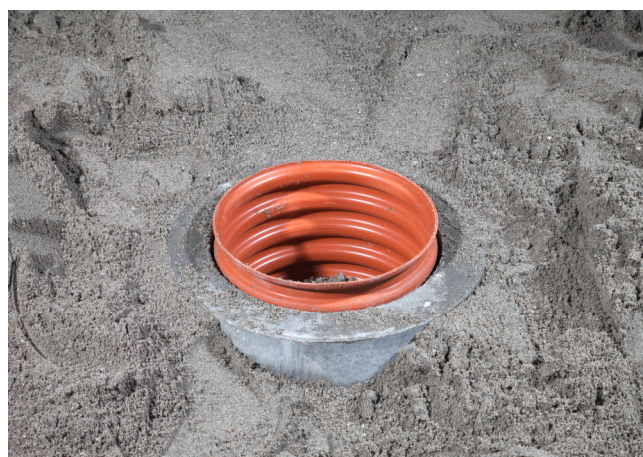
Betonkegle sættes ned over opføringsrøret.
