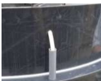
Kabelgennemføring til teknikkasse
